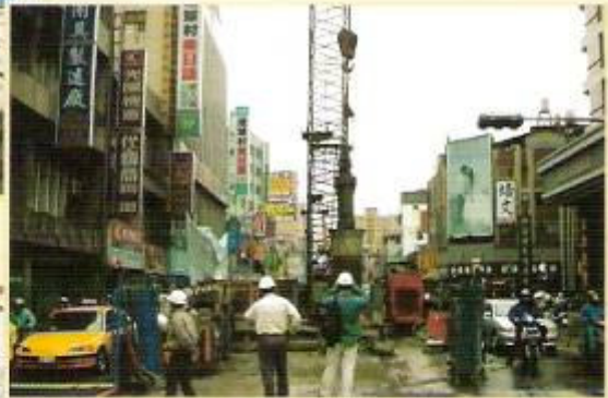
新莊捷運CK570標-中正路路中施工
