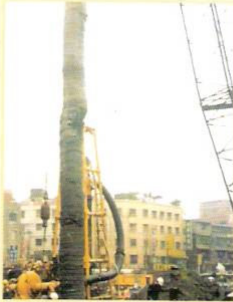
捷運南勢角站-舊樁拔除工程
