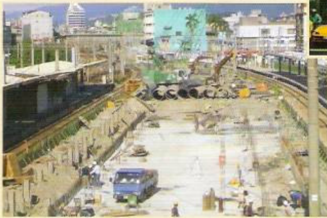
松山車站改建工程
