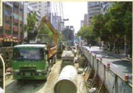
台北捷運CB-430復興北路路中施工
