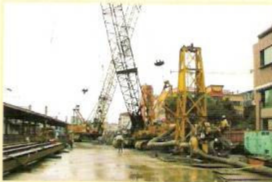
松山車站改建工程
