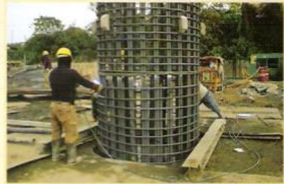
鋼筋籠吊放
