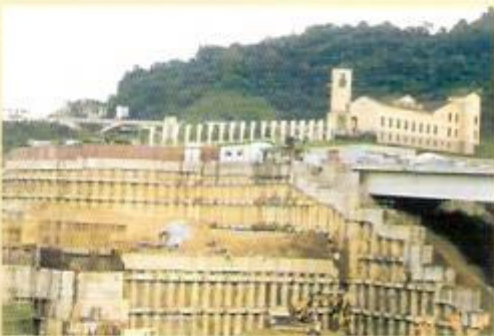
排樁完成區實況-青山鎮
