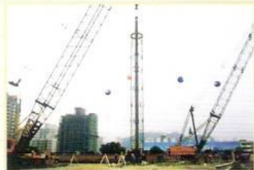
逆打鋼柱吊放施作情況
