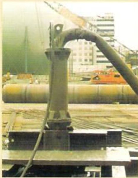
孔底沈泥處理
