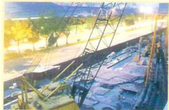
夜間施工情況
