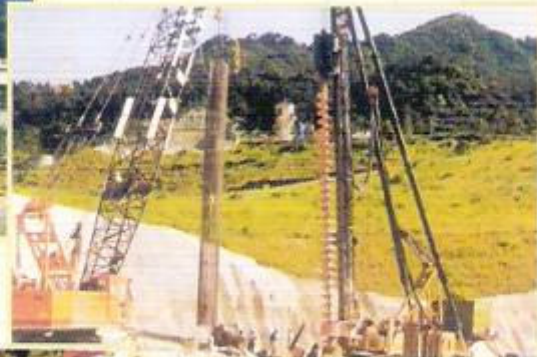
鑽岩機作業中情況
