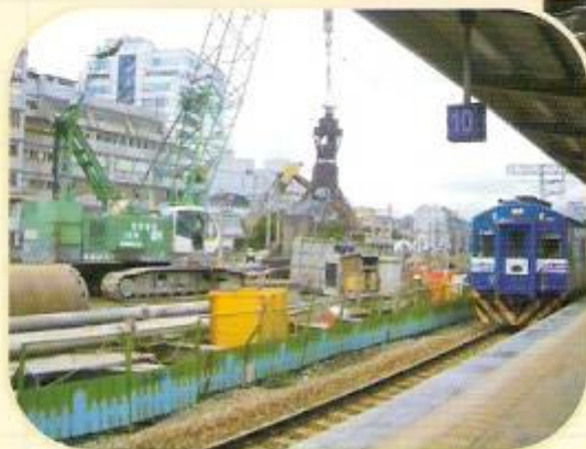
松山車站改建工程
