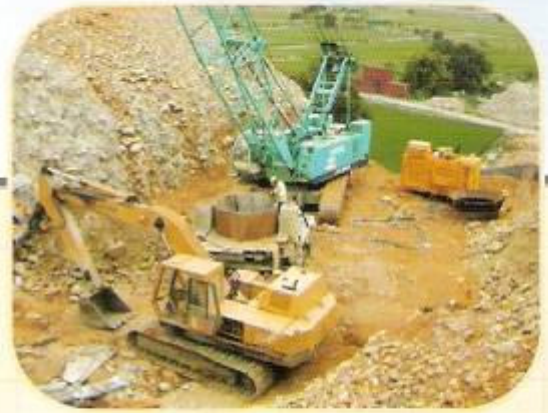
高鐵C250標— 大甲溪全套管工法施工
