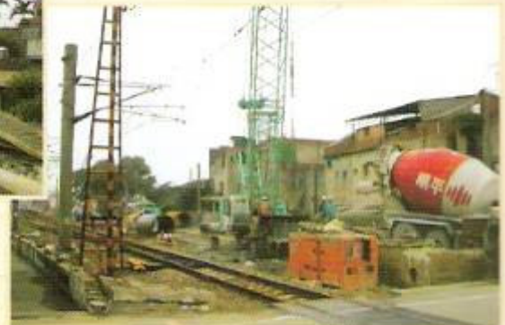
後龍車站改建工程
