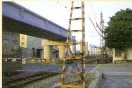
後龍車站改建工程
