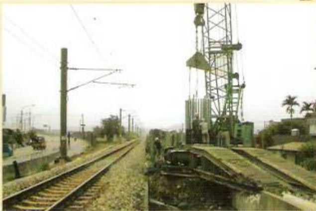
後龍車站改建工程
