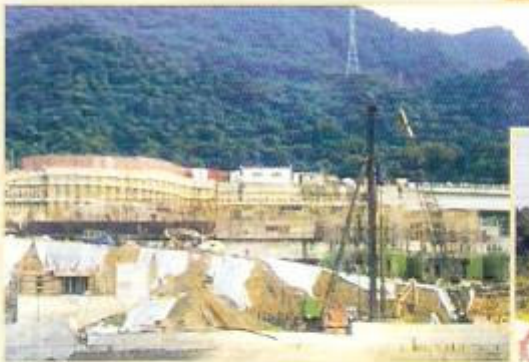
DH-608-120M及D508-100M鑽岩機 同時作業情況
